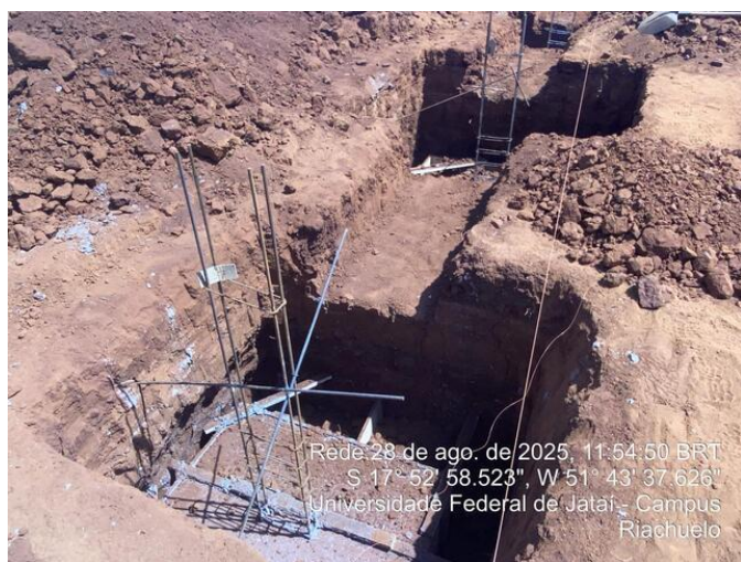
Arranque da sapata concretada
