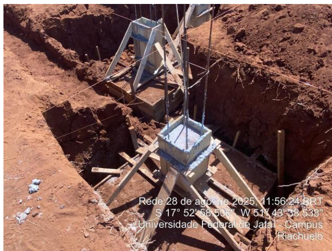
Arranque da sapata concretada
